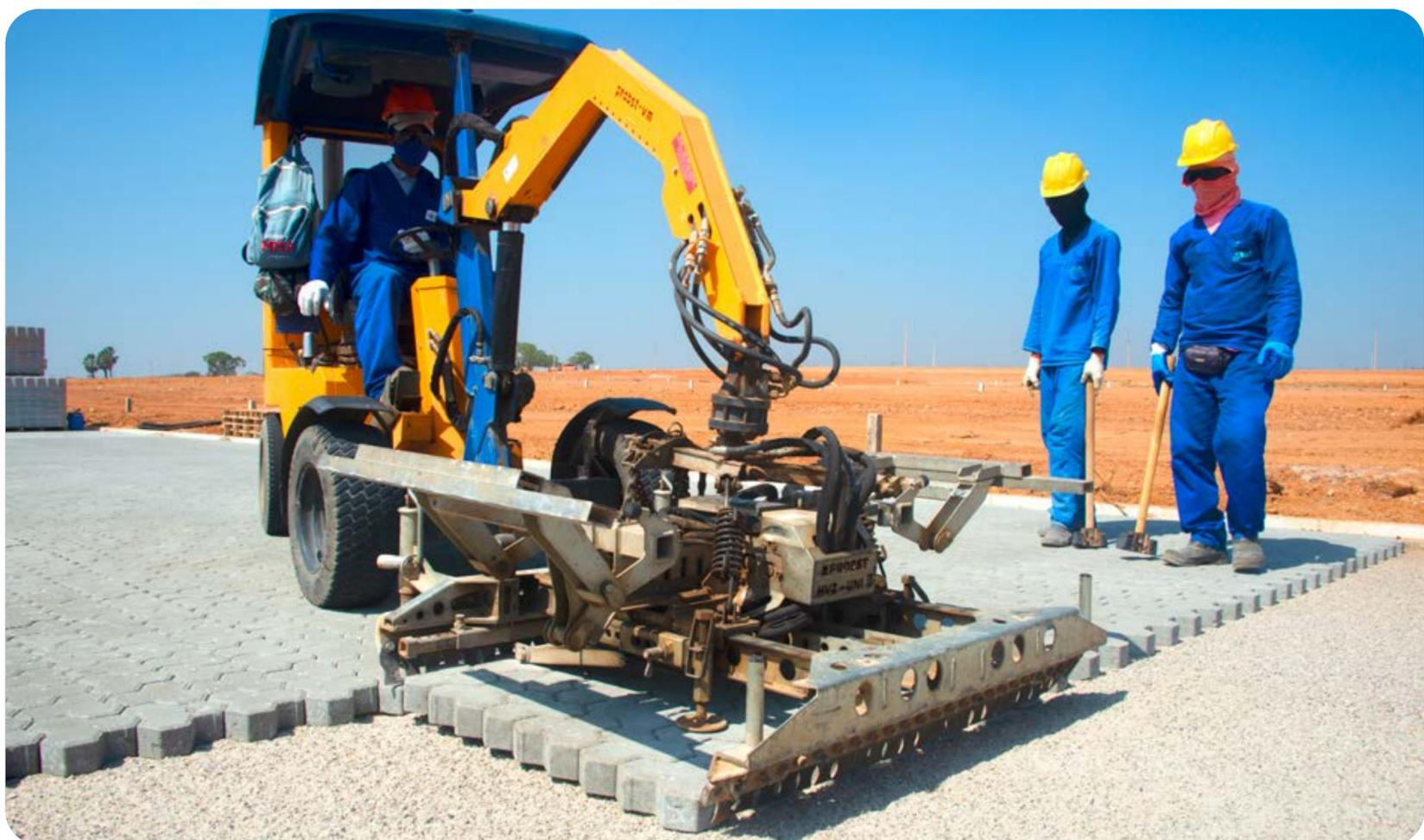
Trazendo uma maior eficiência na obra, a máquina de garra hidráulica empunha de uma só vez 1 m<sup>2</sup> de piso intertravado para aplicação direta no solo. Além da rapidez na construção, aumenta a qualidade, assegurando sua conservação e durabilidade.
